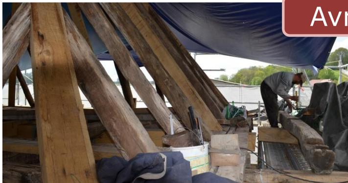
**Charpente du clocher en cours de réalisation**
