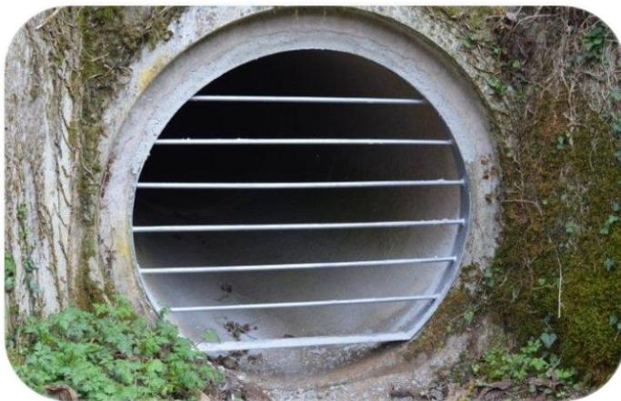
Une grille de protection vient d'être posée sur un exutoire d'écoulement des eaux de pluie, près des poubelles du bas du bourg. Cet ouvrage profond présentait un danger dans cette zone très fréquentée.
