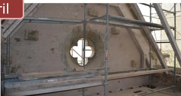
**Le crépi intérieur du narthex est réalisé.**
