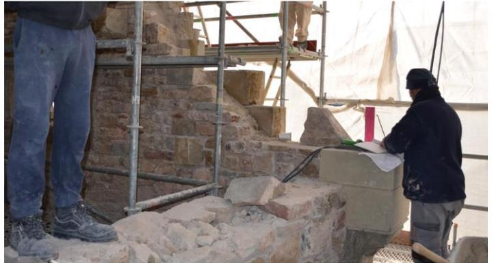
**Au-dessus du narthex, le mur gris du pignon est démonté en partie et consolidé.**
