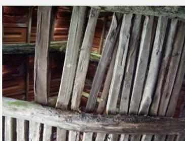
Ces claies laissaient passer la fumée épaisse dégagée depuis la partie basse par un foyer confectionné de souches d'arbres recouvertes de mottes de gazon séchées (**las Glaives**).
