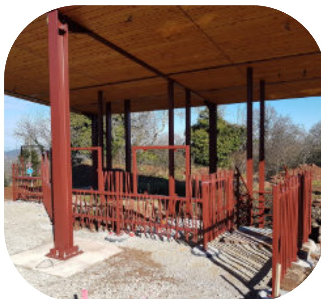
Accès vers la descente d'escalier.
