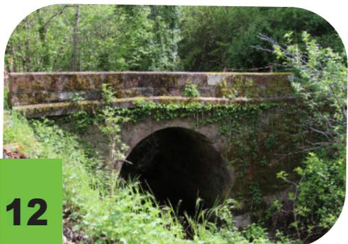
Les marcheurs ont pu constater que ce pont (en bas du bourg) était désormais coupé par de la rubalise. En effet le service départemental des ponts procède à une inspection générale des ponts communaux et ce pont est fissuré en voie centrale. Nous pouvons l'emprunter à pied sans souci mais en revanche aucun véhicule ne doit le traverser. Nous attendons le rapport d'inspection final et les éventuels frais engendrés pour réparer cet élément sympathique de notre habitat.
