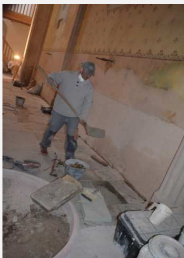
Remplacement d'une dalle et calage du pavage Fin mars 2017
