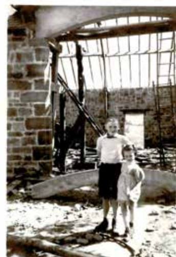
La charpente d'une grange du bourg en cours de réalisation
